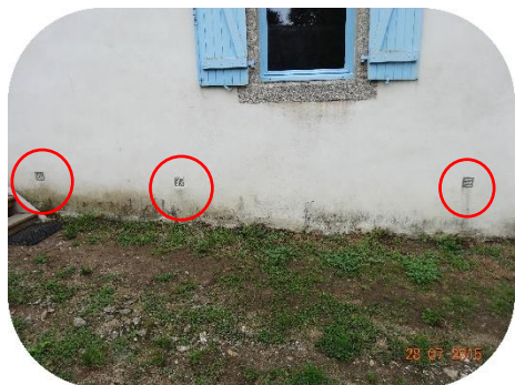
Grilles extérieures du drain côté façade sud
