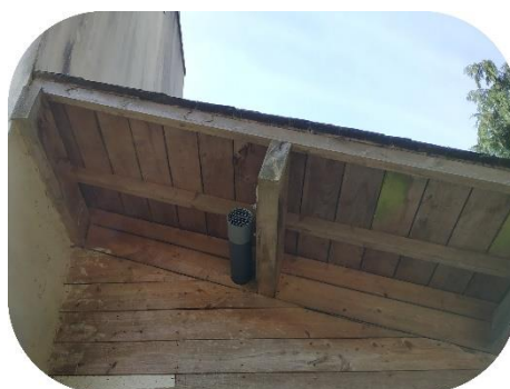
Sortie extracteur SDS sous l'avant-toit du local chaufferie
