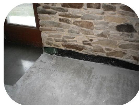
Amenée d'air extérieur pour le poêle du séjour
