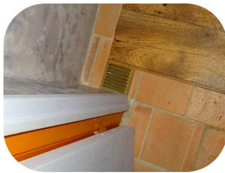
Grille intérieure du drain (exemple sol séjour)
