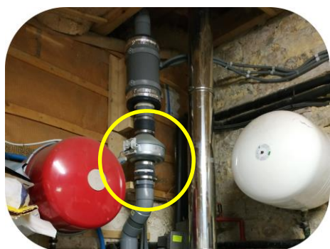
Extracteur du SDS dans le local chaufferie
