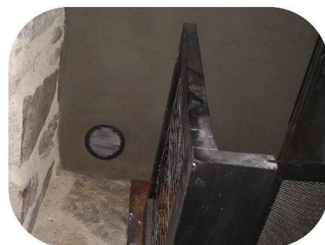
Amenée d'air extérieur pour le poêle du séjour
